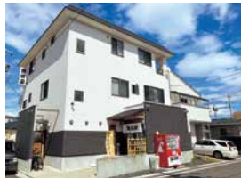
震災後平成27年に再建した店舗
