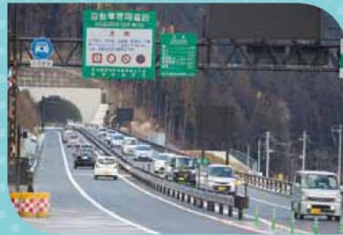
整備が進む三陸自動車道 (田老真崎海岸IC〜田老北IC) 写真提供：岩手河川国道事務所
