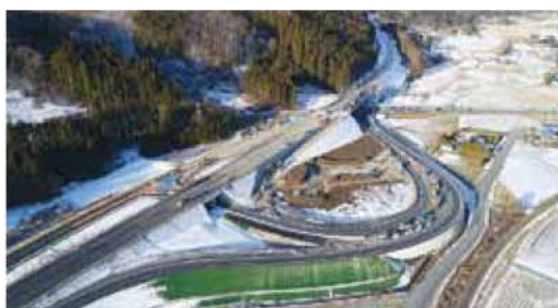
国道340号と連絡する釜石道-遠野住田IC 写真提供：岩手河川国道事務所
