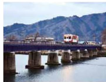
大槌川橋りょうを渡る(上り)。昨年7月18日の同橋りょう部の軌道敷設をもって、釜石駅～宮古駅全区間が一本のレールで結ばれた
