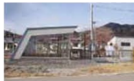
浪板海岸駅の新駅舎
