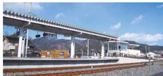
ホームの屋根の色はかつての大槌駅の屋根色と同じ
