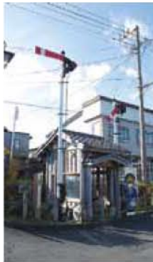
船上にある簡木式信号機。大正13年10月の八戸線開通時から平成17年まで使用されていた。JR東日本の中では最も多くで利用された簡木式信号機で、水平の時は停止(赤)、45度以下がった時は進行(黄)を示す
