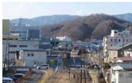
東側から見た宮古駅構内。踏切左手奥に新築された検修庫が見える
