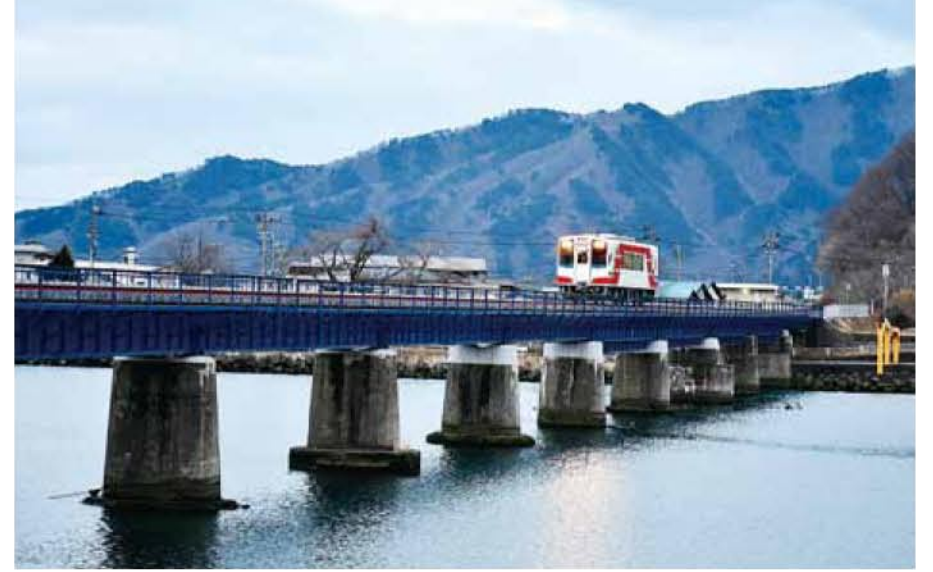
JR東日本により再建された第34閉伊川橋りょうを渡る新造列車
