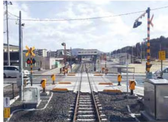
陸中山田駅に入線、約8年ぶりに踏切の警報音が響く
