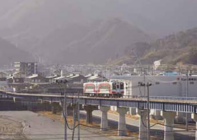
震災時は橋脚ごと流された大槌川橋りょう。背後には復興が進む大槌町の姿が見える
